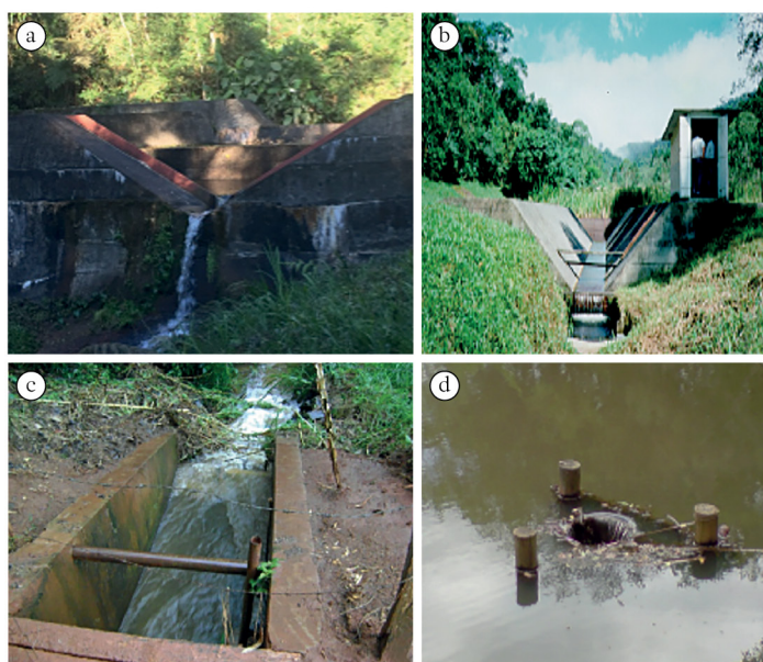
Figura 2.16. Tipos de vertedores para medição da vazão: a) vertedor triangular, b) vertedor trapezoidal, c) vertedor retangular e d) vertedor circular (Fonte: autores).
