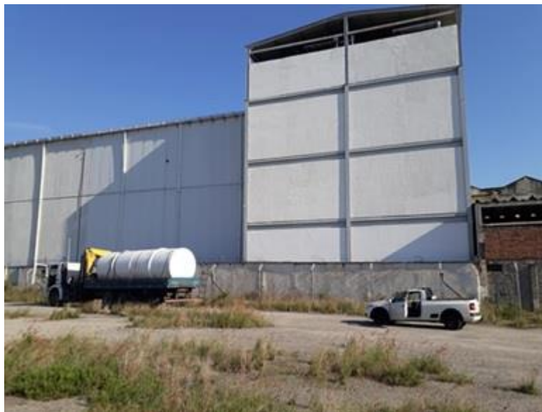
Fig. 5. Imagens da implantação do projeto da planta de estação de tratamento de efluentes industriais. Fonte HY Sustentável LTDA (2018).
