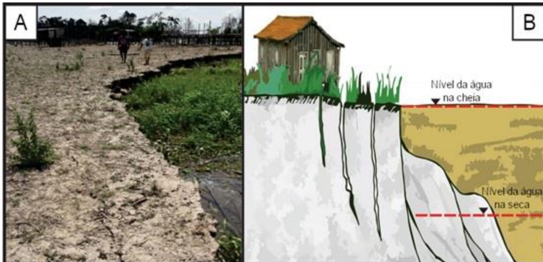
Fig. 11. (a) Um exemplo do fenômeno de “terras caídas” na localidade de São Braz, Porto de Moz, Pará, onde observa-se o enfraquecimento na margem do rio Amazonas, levando à perda de mais de 500 m de terra, causada pela cheia do rio Amazonas em agosto de 2016. (b) Esquema mostrando como ocorre o processo de “terras caídas” durante a inundação. Fonte: Modificado de Bandeira et al. (2018).
