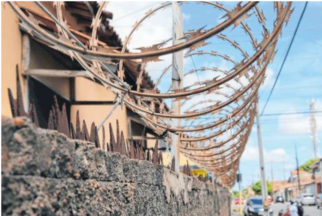
FOTOGRAFIA 1. Concertinas eletrificadas. Fortaleza, CE
