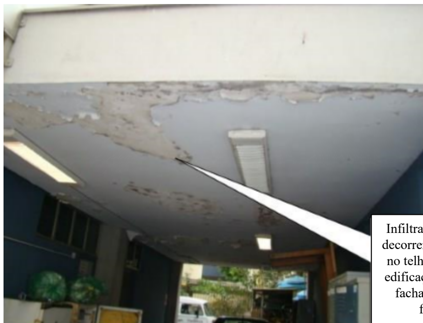
Figura 10. Infiltração generalizada.
