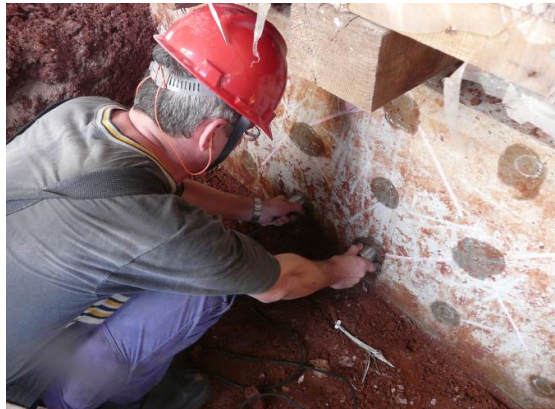
Figura 1: Execução do Ensaio de VPU
