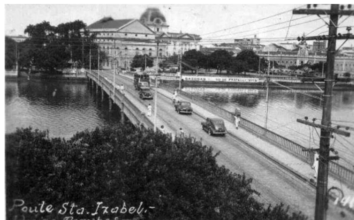
Figura 3: Ponte Princesa Isabel com a estrutura de concreto
