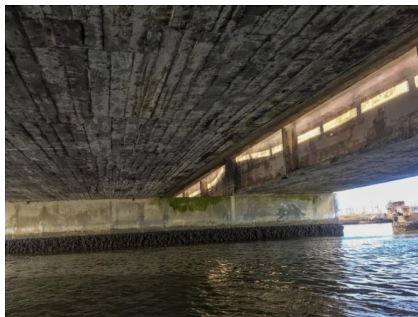
Figura 8: Estrutura da Ponte 12 de Setembro
