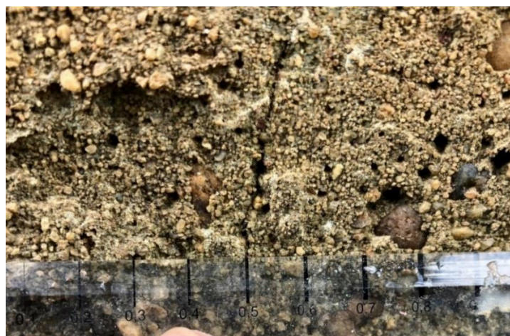
Figura 6: Porosidade do concreto, P1
