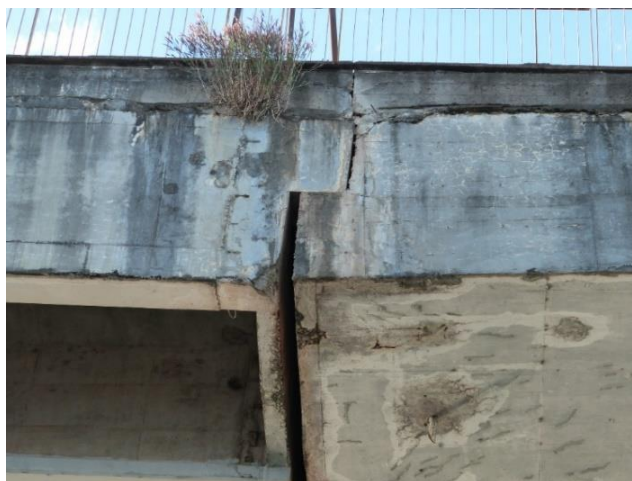
Figura 15: Gerber situado entre os pilares P1 e P2
