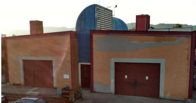
Figura 9 - Fachada dos Laboratórios
