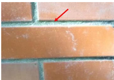
Figura 10 - Verificação das juntas
