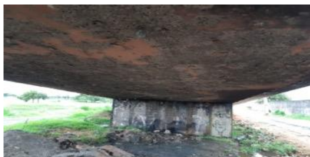
Figura 4 - Laje entre os pilares 13 e 14
