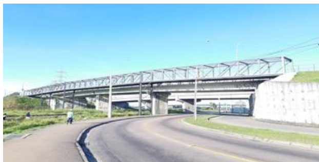
Figura 3 – Viadutos Comendador Franco
