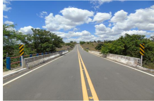
Figura 14: Ponte sobre o Riacho Grande – Ponte se acostamento.
