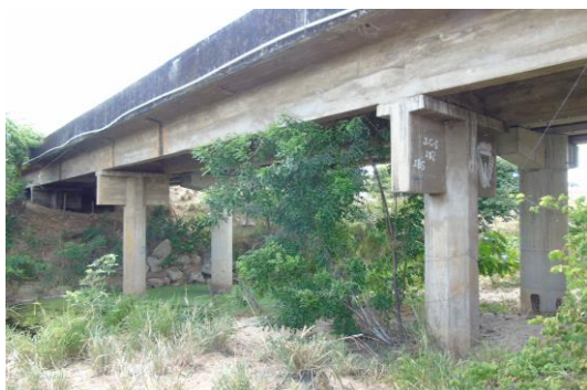
Figura 7: Vista longitudinal da OAE.
