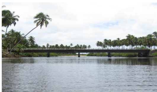
Figura 1: Vista longitudinal da OAE.
