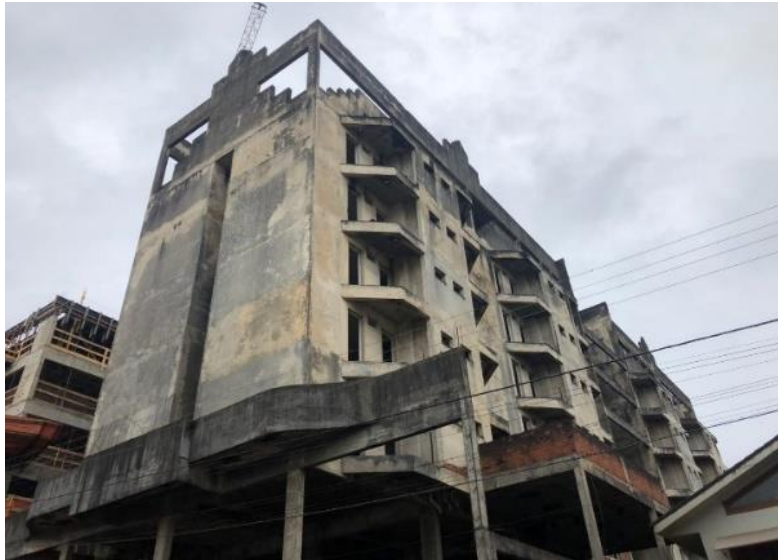
Figura 2 – Vista Frontal e Lateral (Sul)
