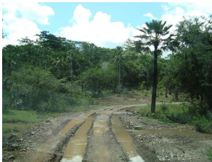
Figura 8: Estrada vicinal comprometida por atoleiro
