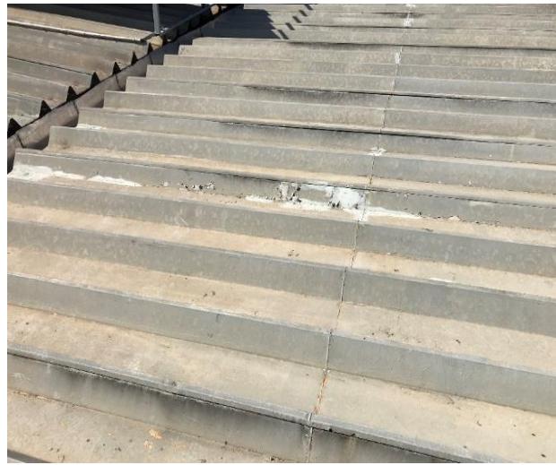
Figura 4: Falta de calafetação e (ou) substituição das telhas
