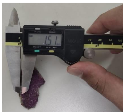
Fragmento extraído do canto superior do tubulão 4, localizado no centro da estrutura.
