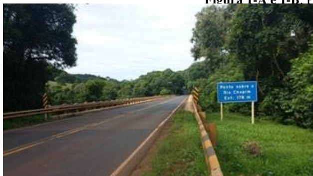
Figura 1-A e 1-B: Ponte Rio Chonim
