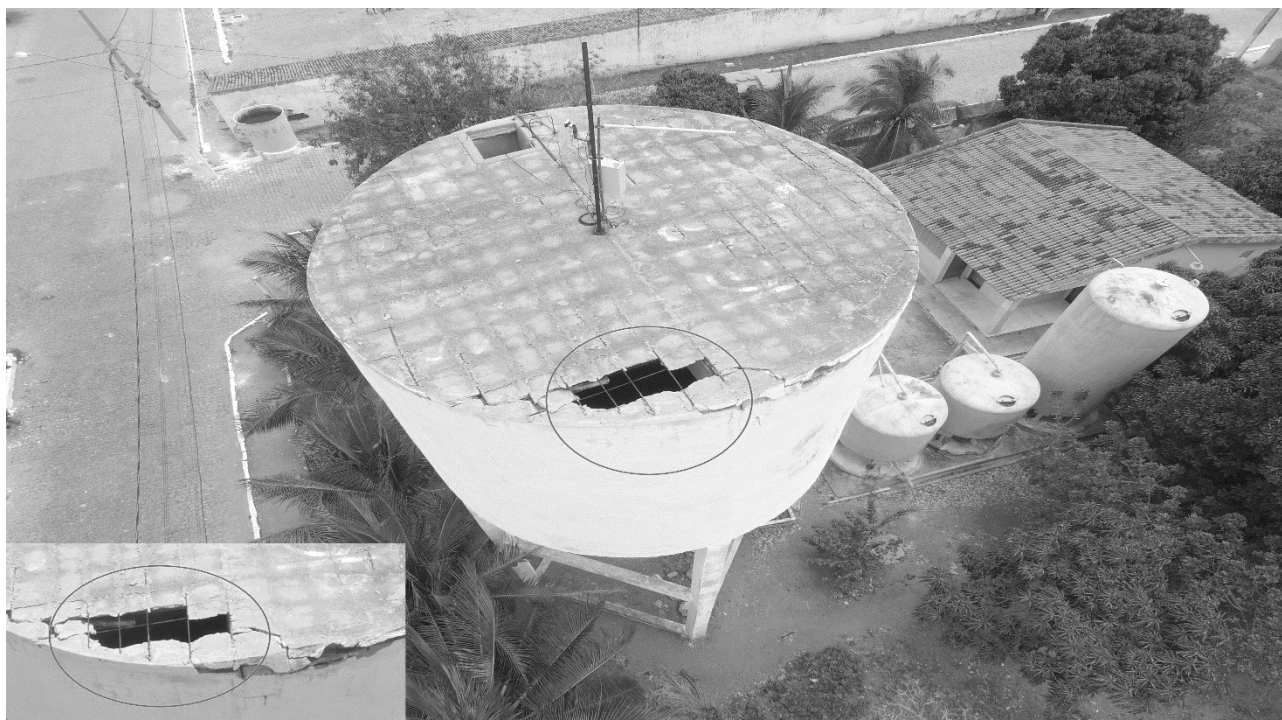
Figura 1: Vista superior do reservatório elevado localizado na cidade da Prata-PB
