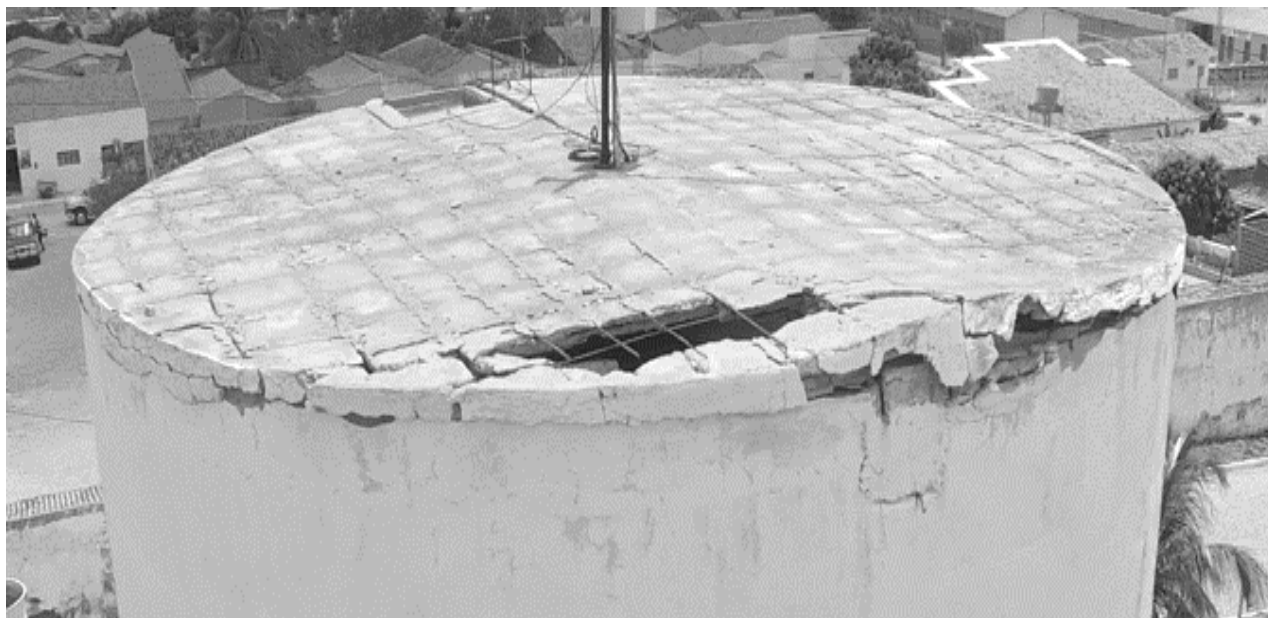
Figura 2: Vista lateral sul do reservatório-
