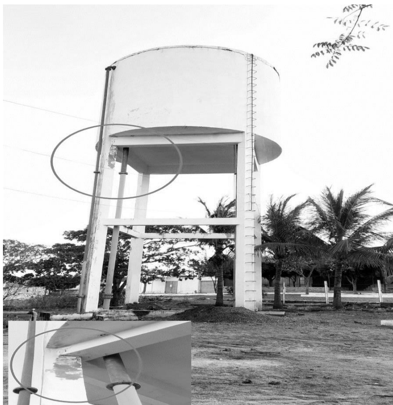
Figura 4: Reservatório elevado da cidade da Prata-PB
