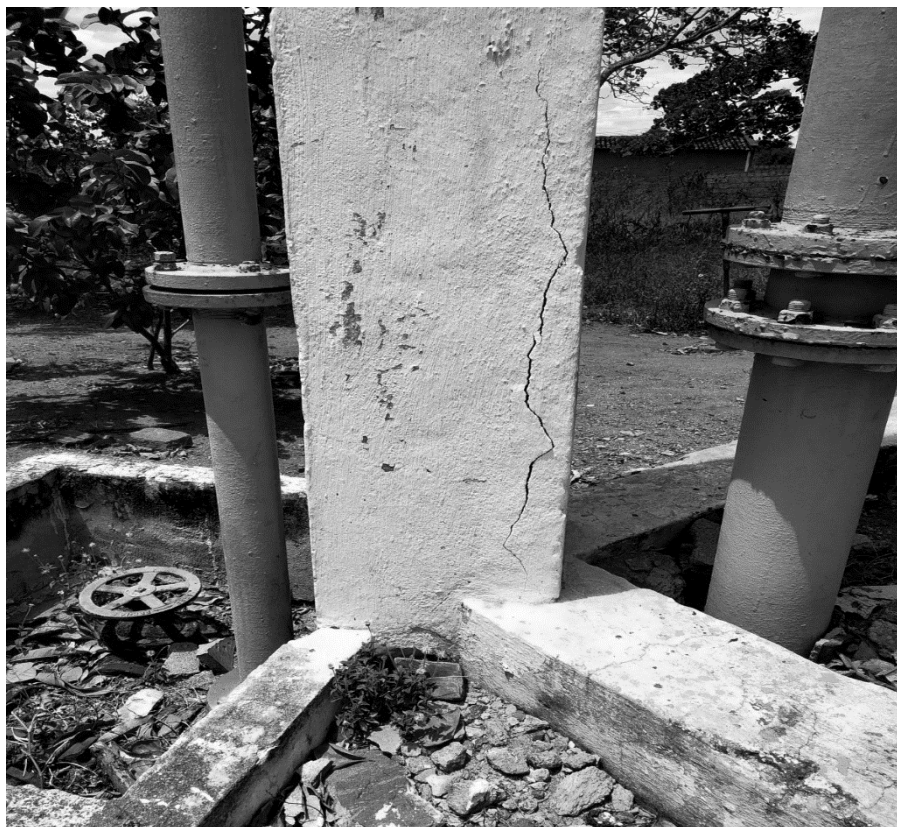
Figura 3: Pilar sentido leste do reservatório
