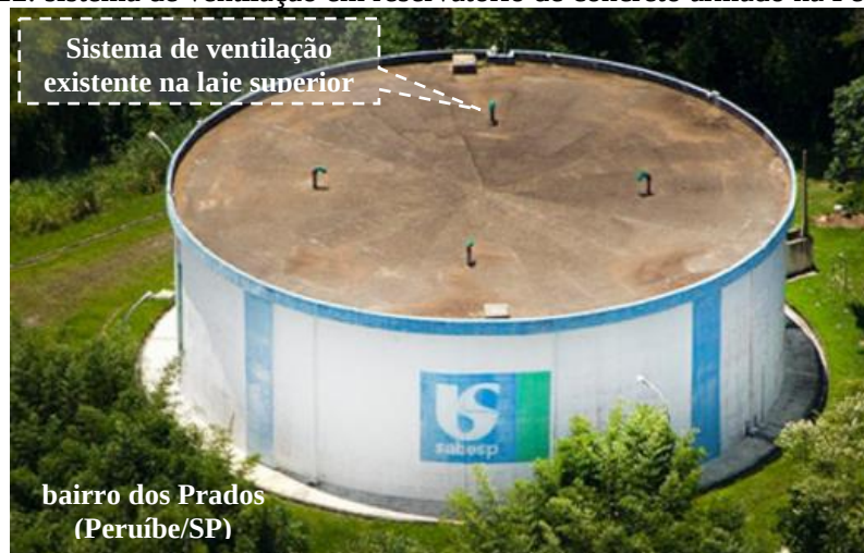
Figura 12: sistema de ventilação em reservatório de concreto armado na Peruíbe/SP.
