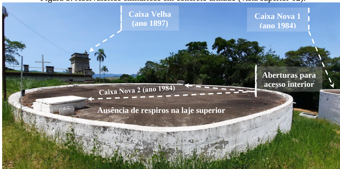
Figura 5: reservatórios cilíndricos em concreto armado (vista superior 02).
