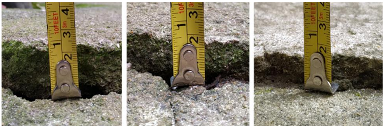
Figura 7 – Medição dos pontos de elevação 1, 2 e 3, respectivamente.
