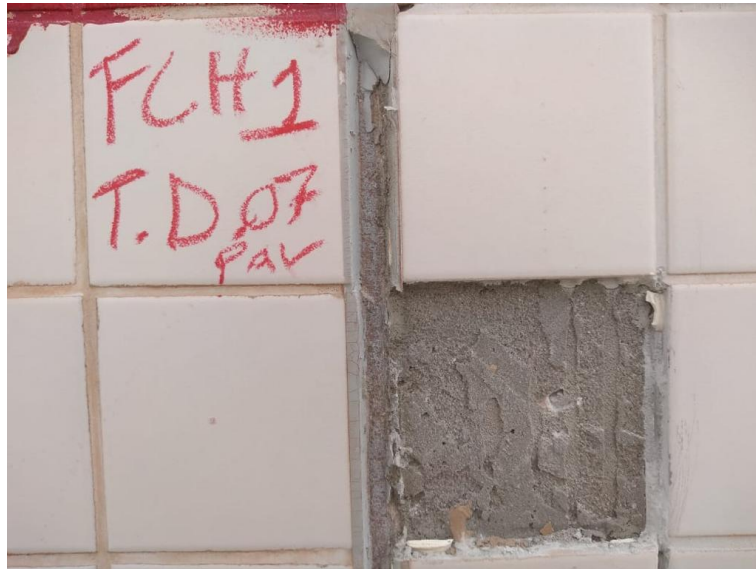
Figura 7 – Verificação do corte do emboço
