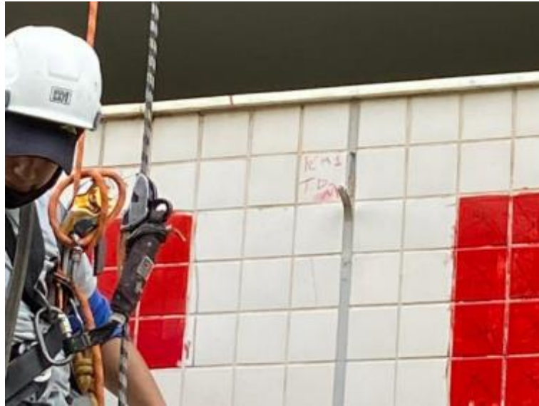
Figura 4 – Ensaio destrutivo nas juntas de movimentação: corte e abertura do material de preenchimento
