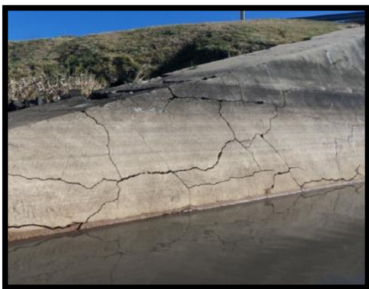
(a) Parede do dique de uma barragem.
