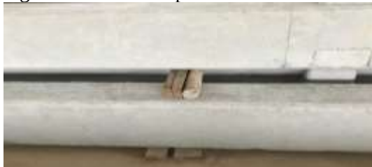
Figura 9 - Ponto de apoio alinhado na vertical
