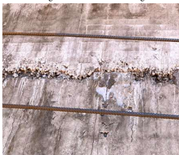
Figura 8- Ninhos de concretagem
