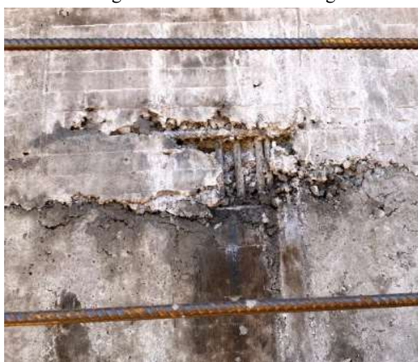
Figura 7- Ninhos de concretagem
