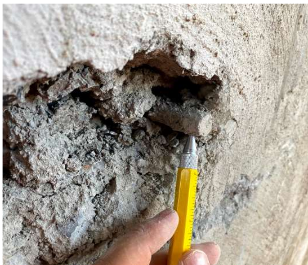
Figura 5 – Utilização de armadura como espaçador
