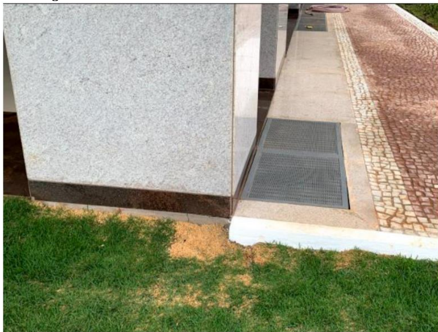
Figura 13 – Região na área de influência de ambas as obras, vistoriada no dia 03/11/2020
