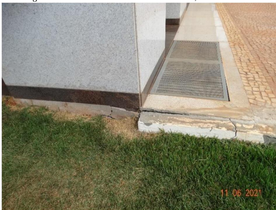
Figura 14 – Região na área de influência de ambas as obras, vistoriada no dia 11/06/2021
