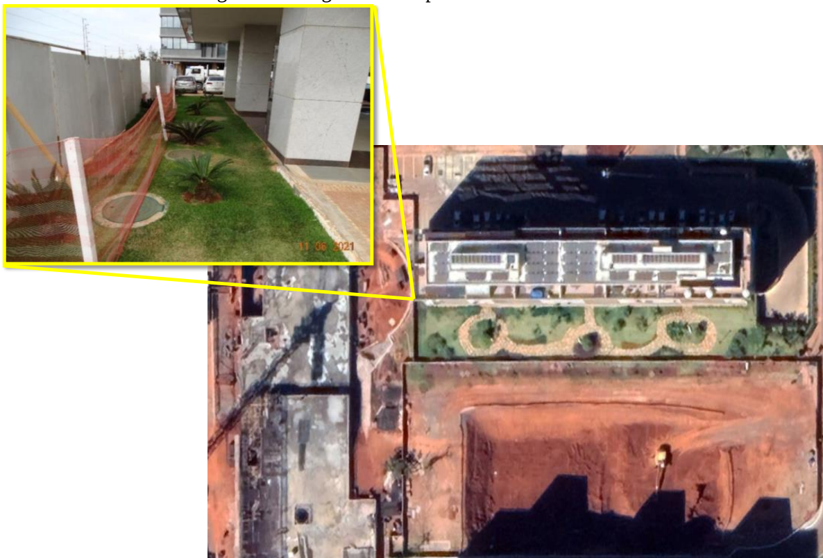
Figura 12 – Região afetada pelo 1º canteiro de obras
