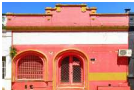
Figura 1. Fotografia da fachada sem interferências.
