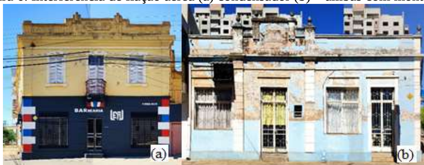
Figura 6. Interferência de fiação aérea (a) condensador (b) – ambas com montagem.
