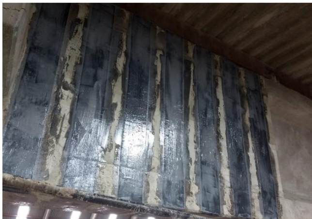
Figura 10 – Fibra de carbono executada
