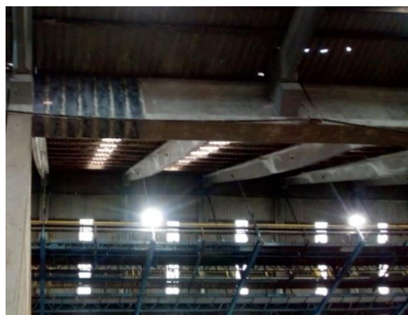
Figura 11 – Fibra de carbono executada
