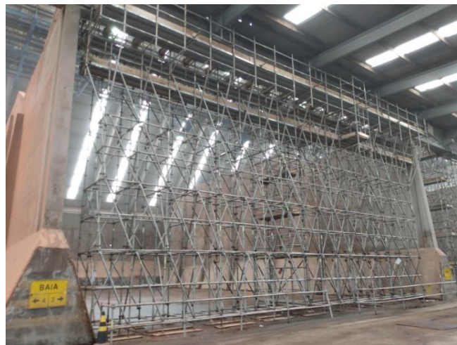
Figura 5 - Vista frontal da viga com escoramento
