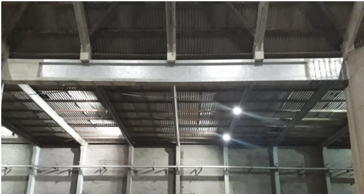
Figura 14 – Vista frontal viga com reforço executado
