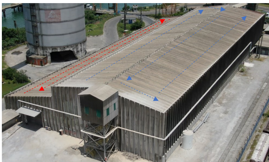
Figura 3: Vista aérea da cobertura do galpão objeto da vistoria.
