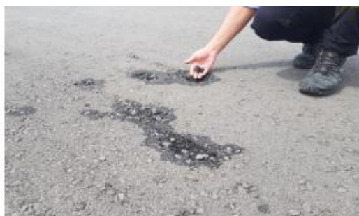
Figura 9c- Desagregação do material
