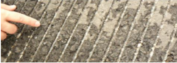
Figura 6 – Desagregação superficial
