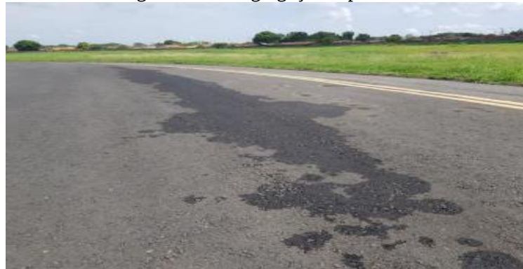
Figura 8 – Desagregação superficial
