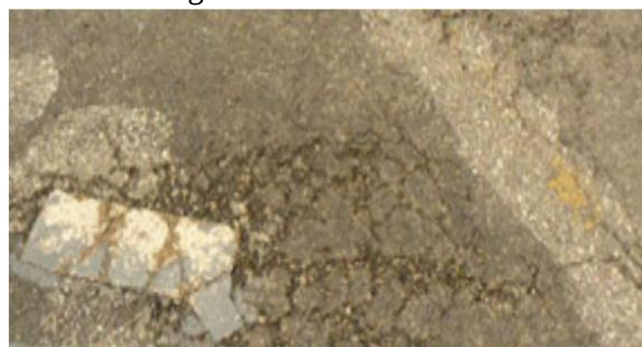
Figura 3 – Trincas isoladas
