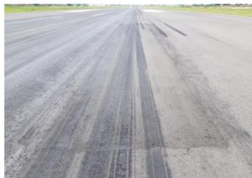
Figura 9b-Remendo com 15,20 m de comprimento
