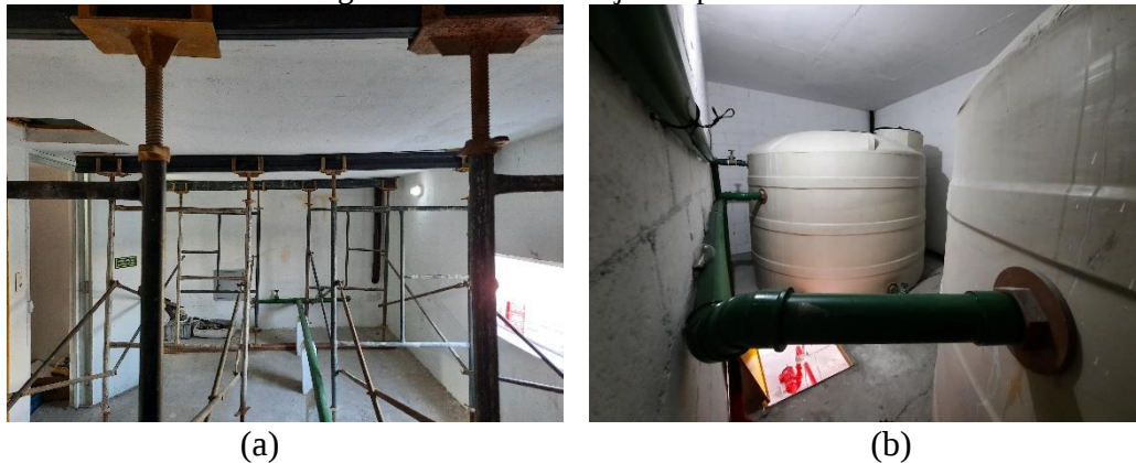
Figura 2 – Vistas das lajes inspecionadas
