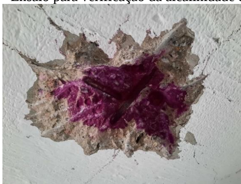
Figura 10 – Ensaio para verificação da alcalinidade do concreto
