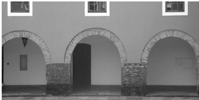
Figura 11 - Vista dos pilares úmidos após a ação das chuvas (capilaridade) Fonte: Arquivos IPHAN (2017).
