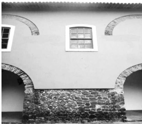
Figura 5 – Efeito de capilaridade Fonte: Arquivos IPHAN (2017)
