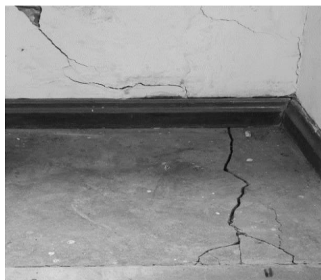
Figura 8 - Pavimento superior Fonte: Arquivos IPHAN (2017)
