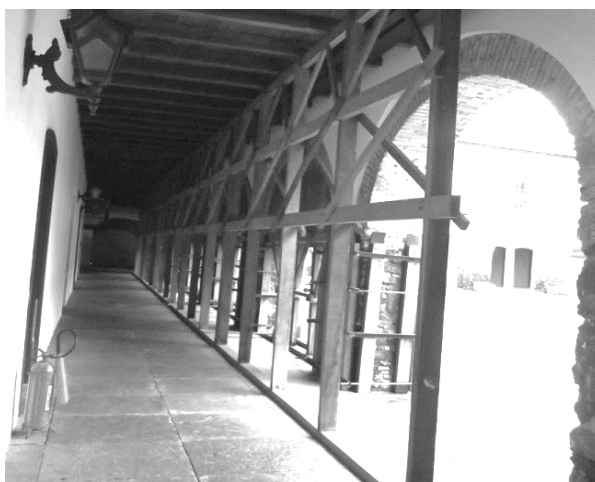
Figura 9 – Piso constituído por barrotes de madeira. Fonte: Wadson Carvalho (2017)
