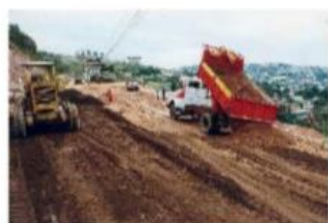
(c) Execução de aterro (PINTO, 1999)
