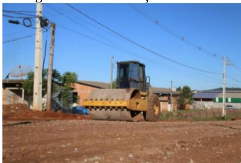
Figura 4 - Pavimentação com RCD
