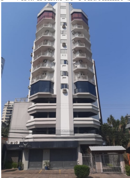
Figura 1 – Vista frontal do Condomínio Skorpius
