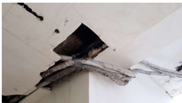
Figura 8 - Passagem da tubulação danificando o forro e passando pela viga (A) e detalhe da passagem da tubulação perfurando a viga (B).
