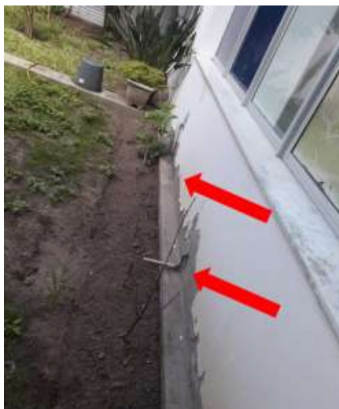
Figura 7 - Tubo de PVC usado como dreno, atravessando a parede ao lado externo da edificação.
