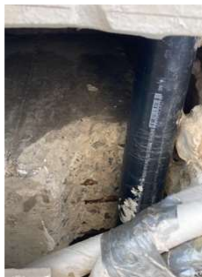
Figura 8 - Passagem da tubulação danificando o forro e passando pela viga (A) e detalhe da passagem da tubulação perfurando a viga (B).
