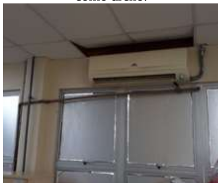
Figura 5 - Tubo de PVC aparente sendo utilizado como dreno.
