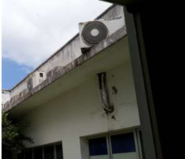
Figura 9 - Passagem de tubulação sob laje.
