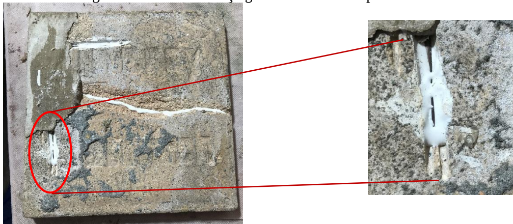
Figura 14 – Arames de aço galvanizado unindo partes dos ladrilhos.
