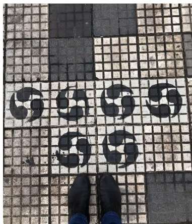
Figura 3 – Ladrilhos hidráulicos em calçadas. Bairro Liberdade - SP
