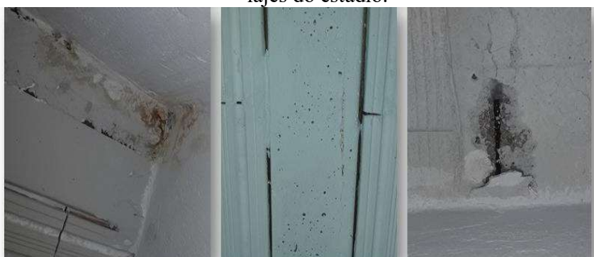
Figura 11. Fissuras, umidade nas extremidades e rachaduras com armadura exposta nas lajes do estádio.
