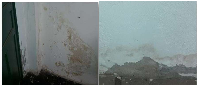
Figura 7. Vestiário dos atletas. Eflorescências e destacamento de pintura por ação de umidade mapeados.
