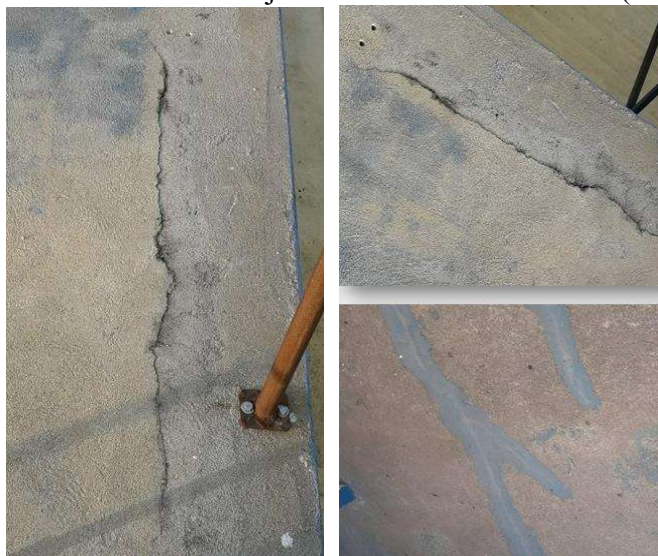
Figura 11. Fissuras, umidade nas extremidades e rachaduras com armadura exposta nas lajes do estádio.
