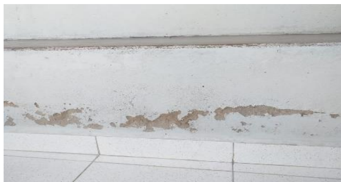
Figura 6 - Destacamento do revestimento na parte inferior das alvenarias.
