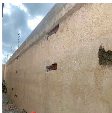
Figura 6 - Amarração em “Z” nas fissuras mapeadas
