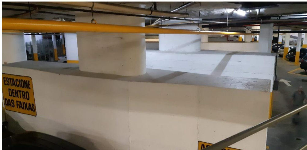
Figura 3 – Reforços de fundação do edifício Copan
