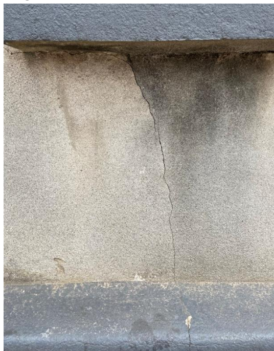
Figura 19 - Fissura - Edificação 02 “7-815”
