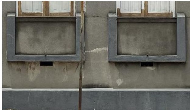
Figura 16 - Embasamento pintado - Edificação 02 “7-815”
