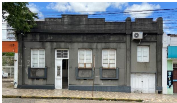
Figura 4 - Edificação 02 “7-815” situada na Av. General Osório, 815
