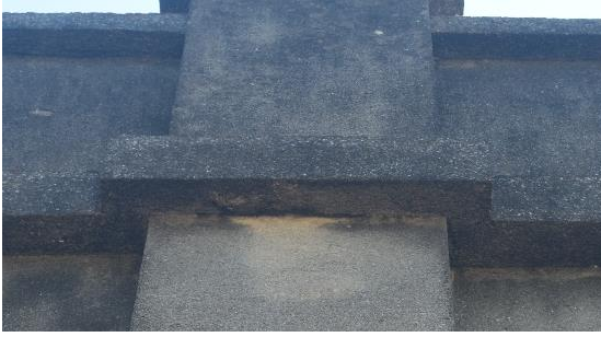
Figura 11 - Eflorescência - Edificação 01 “194-1644”
