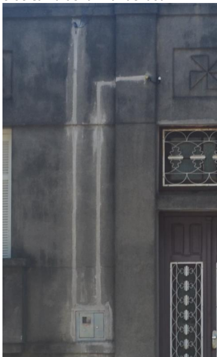
Figura 17 - Inserção de caixa de luz na fachada - Edificação 01 “194-1644”
