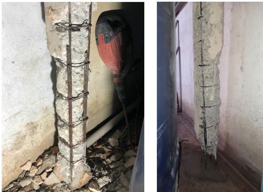
Figura 5 - Pilares escareados. Fonte: Autores, 2022.
