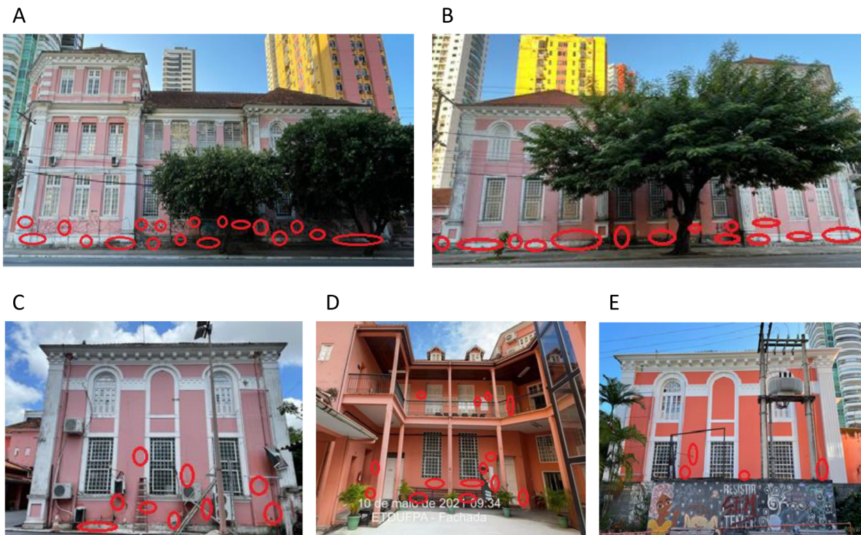
Figura 4: Demarcação das áreas em que o ensaio de percussão foi realizado. (A) Fachada F1, (B) Fachada F2, (C) Fachada F3, (D) Fachada F4 e (E) Fachada F5
