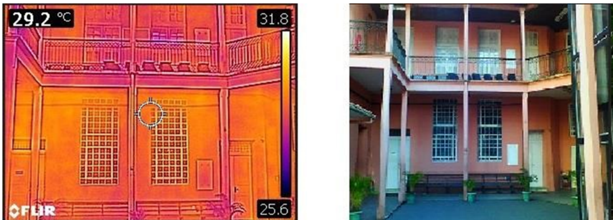
Figura 7: Termografia da Fachada F5.
