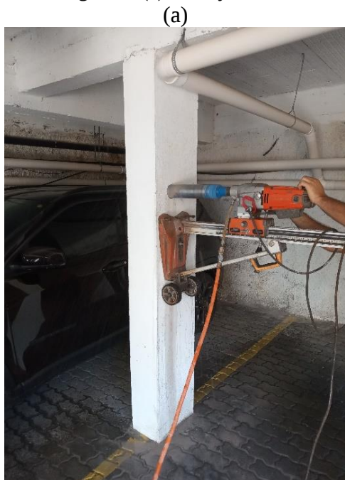
Figura 6. (a) Extração de testemunho de concreto e (b) avaliação por pacometria.
