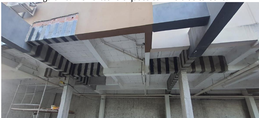
Figura 10. Elementos reforçados com fibra de carbono.
