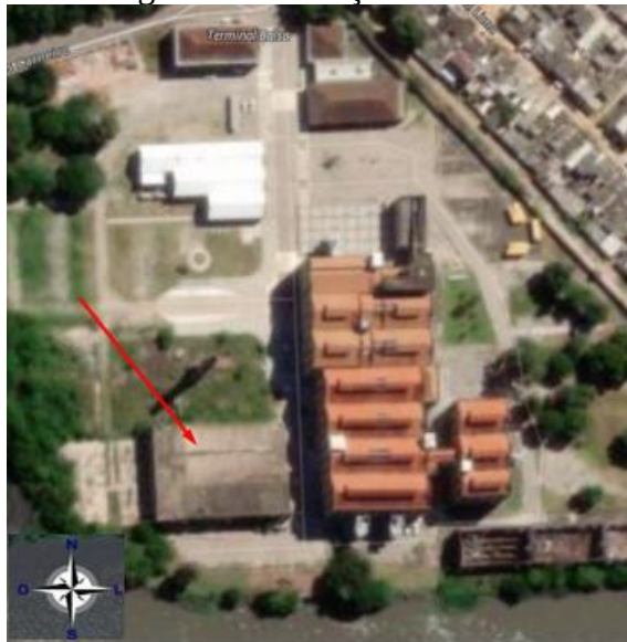
Figura 2: Edificação do estudo
