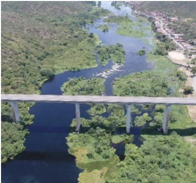
Figura 1- Vista superior da ponte
