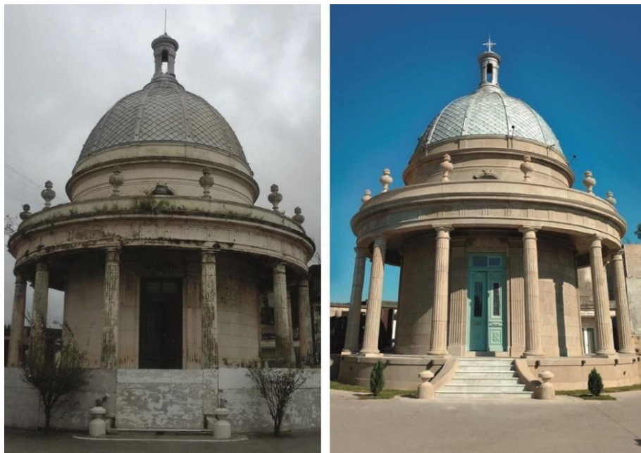
Figura 2 – El Oratorio antes y después de su recuperación
