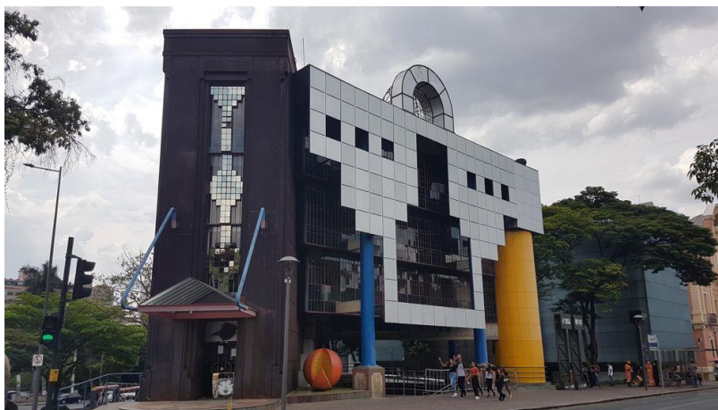
Figura 2 – Vista do prédio Rainha da Sucata, na cidade de Belo Horizonte, que foi construído com aço tipo corten. Destaca-se a cor vermelho amarronzada do aço após o período de formação da pátina. [5]
