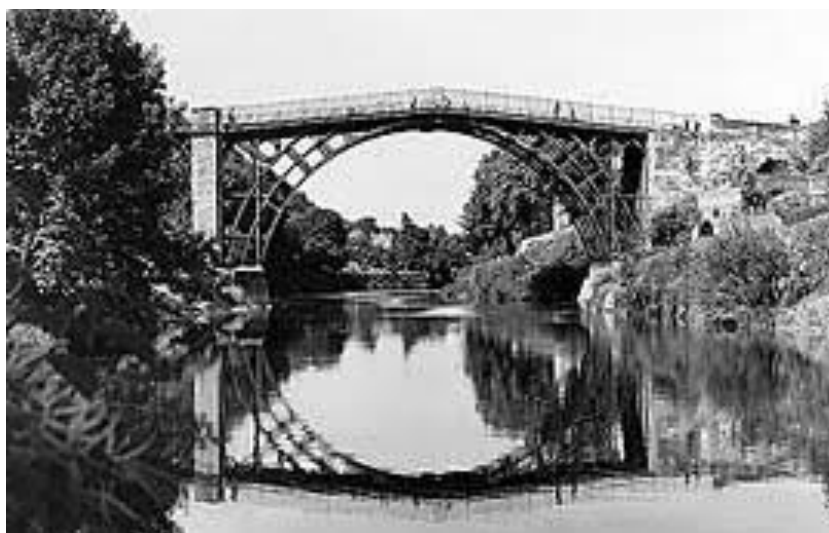
Figura 1 – Vista lateral da Ponte Iron Bridge. [1]
