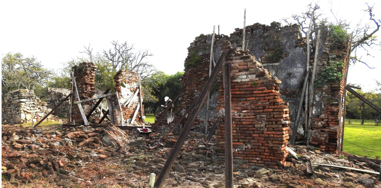
Figura 1- Vista general de los seis paños de muro
