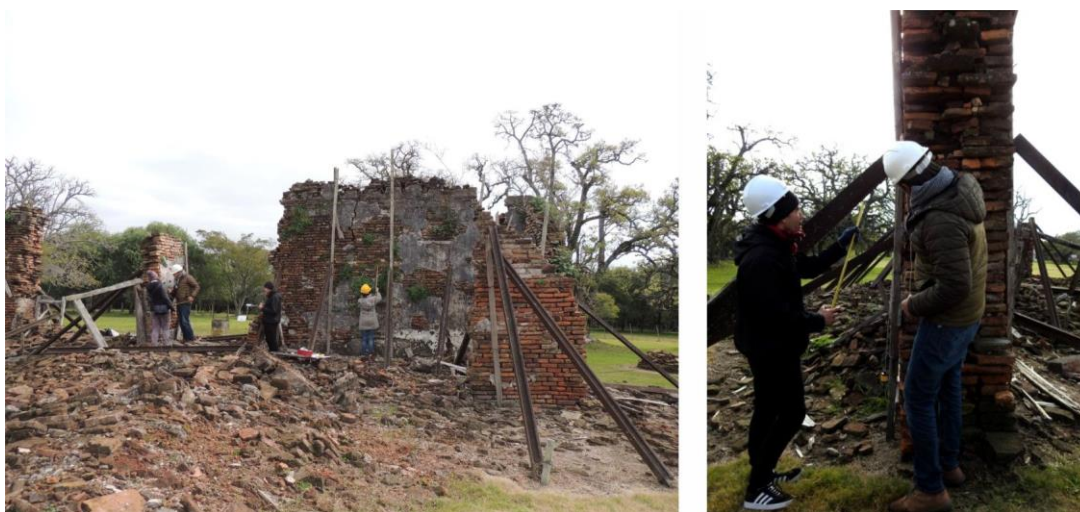
Figura 2- Trabajo in situ
