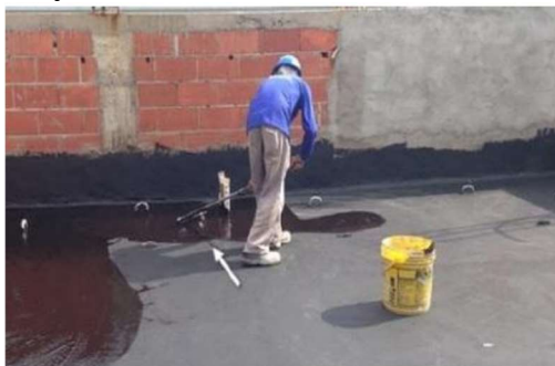
Figura 3 – Execução de membrana de asfalto à frio com rolo de pintura.
