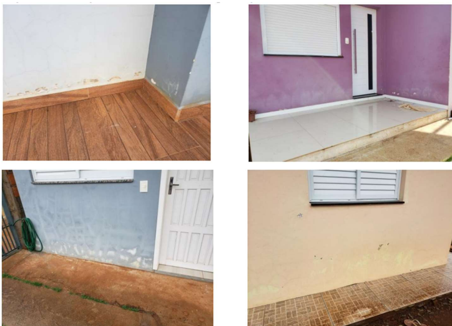
Figura 7 – Fotografias de manifestações patológicas decorrentes da umidade ascensional.
