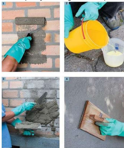
Figura 1 – Aplicação de argamassa impermeável.
