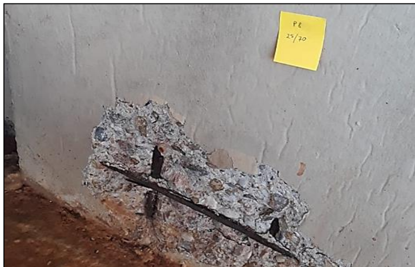
Figura 4 - Etiqueta de identificação do pilar e suas dimensões (P8 25/70) conforme as-built
