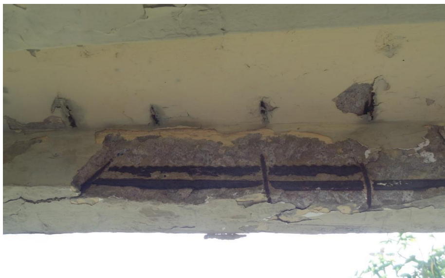
Figura 5 – Desprendimento da camada de concreto
