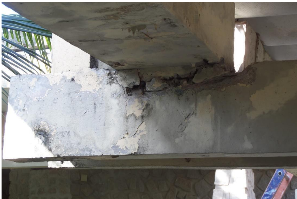
Figura 5 – Desprendimento da camada de concreto
