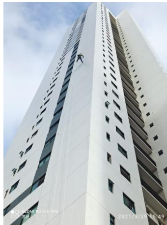
Figura 7 – Ensaio de Percussão por cadeira suspensa
