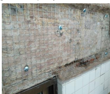
Figura 10 – Aplicação de tela sobre viga
